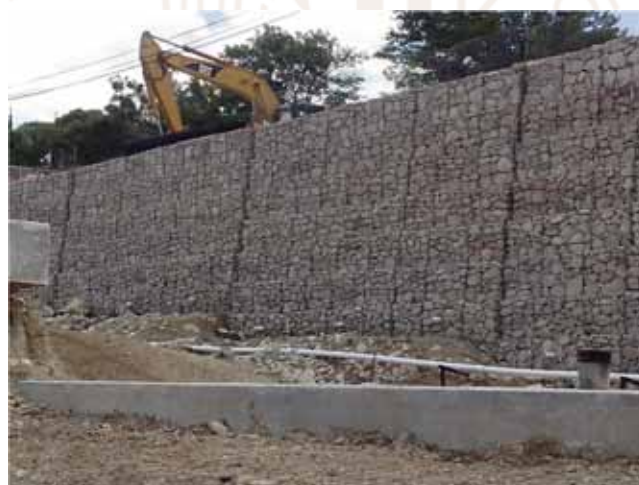
Fig. 6 Estado actual del MME
