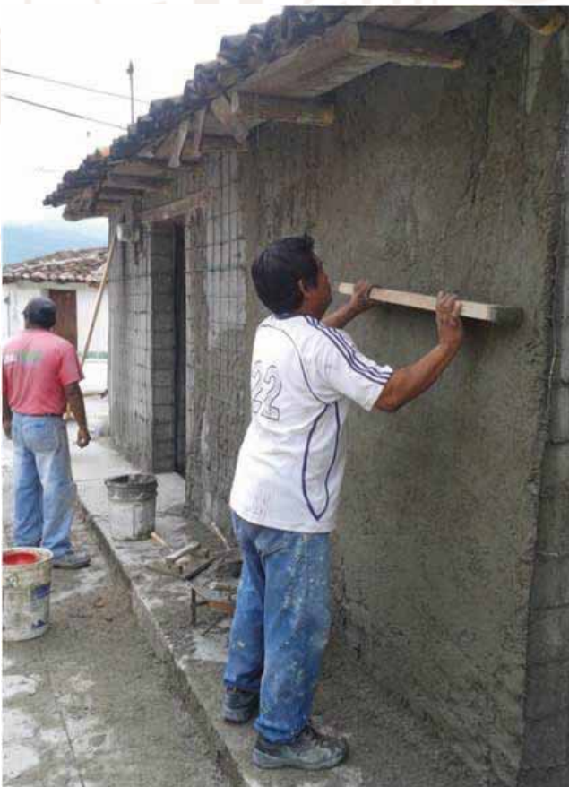
Foto 3. Aplicación de la segunda capa de mortero cemento-arena. Obsérvese que previamente se colocó la malla electrosoldada de acero (6x6/10x10).
