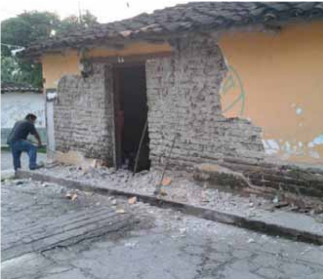
Foto 2. Retiro del aplanado existente tanto en el exterior como en el interior de la vivienda tradicional de adobe.
